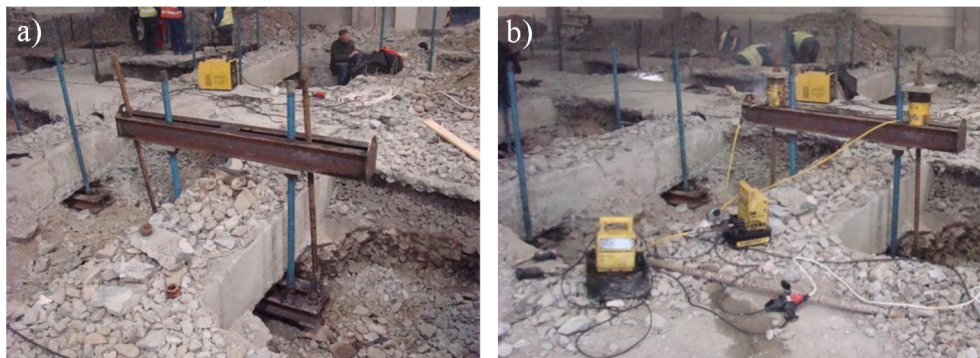
Rys. 12. Prace remontowe: a) przygotowanie do niwelacji, b) poziomowanie rusztu.
