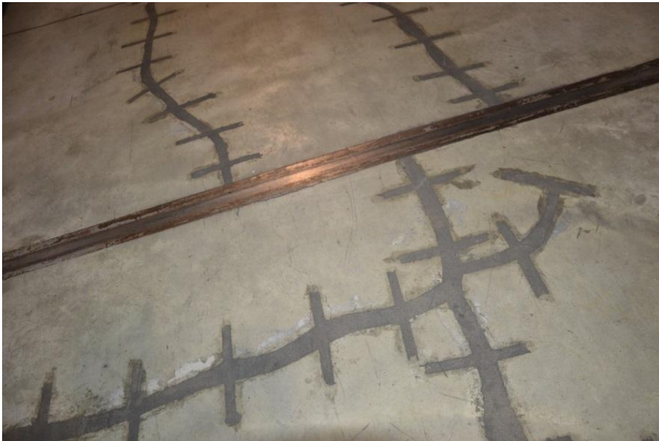
Rys. 4. Rysy naprawione przez szycie.
